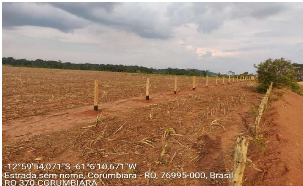
REMOÇÃO E EXECUÇÃO DE CERCAS
