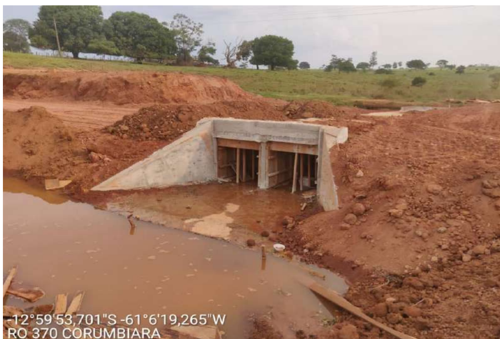
EXECUÇÃO DE BDCC 1,50m X 1,50m ESTACA 901 + 09m
