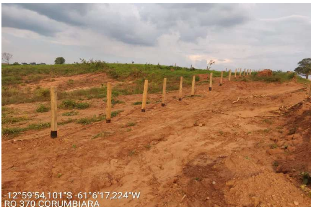
REMOÇÃO E EXECUÇÃO DE CERCAS
