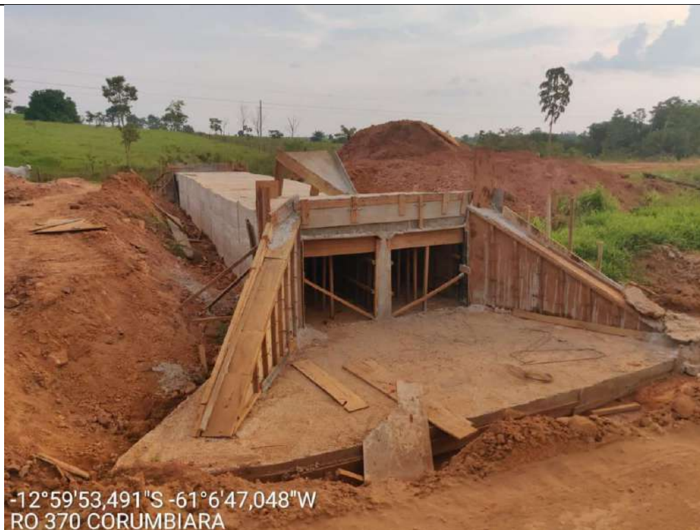
EXECUÇÃO DE BDCC 1,50m X 1,50m ESTACA 857 + 11,00m
