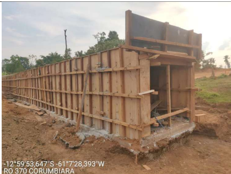
EXECUÇÃO DE BSCC 1,50m X 1,50m ESTACA 962
