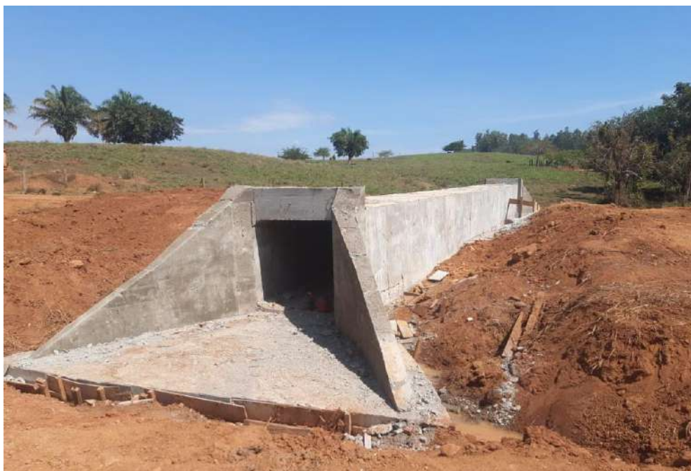
EXECUÇÃO DE BSCC 1,50m X 1,50m ESTACA 962
